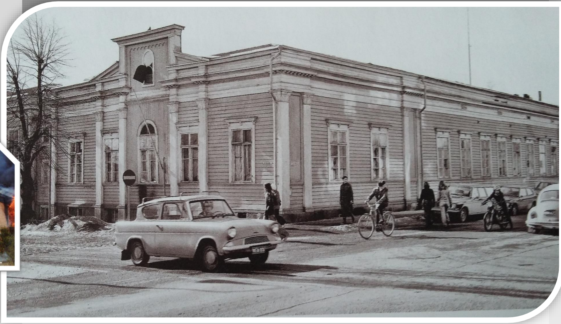
Byggnadskomplexet från 1866 fick förfalla
