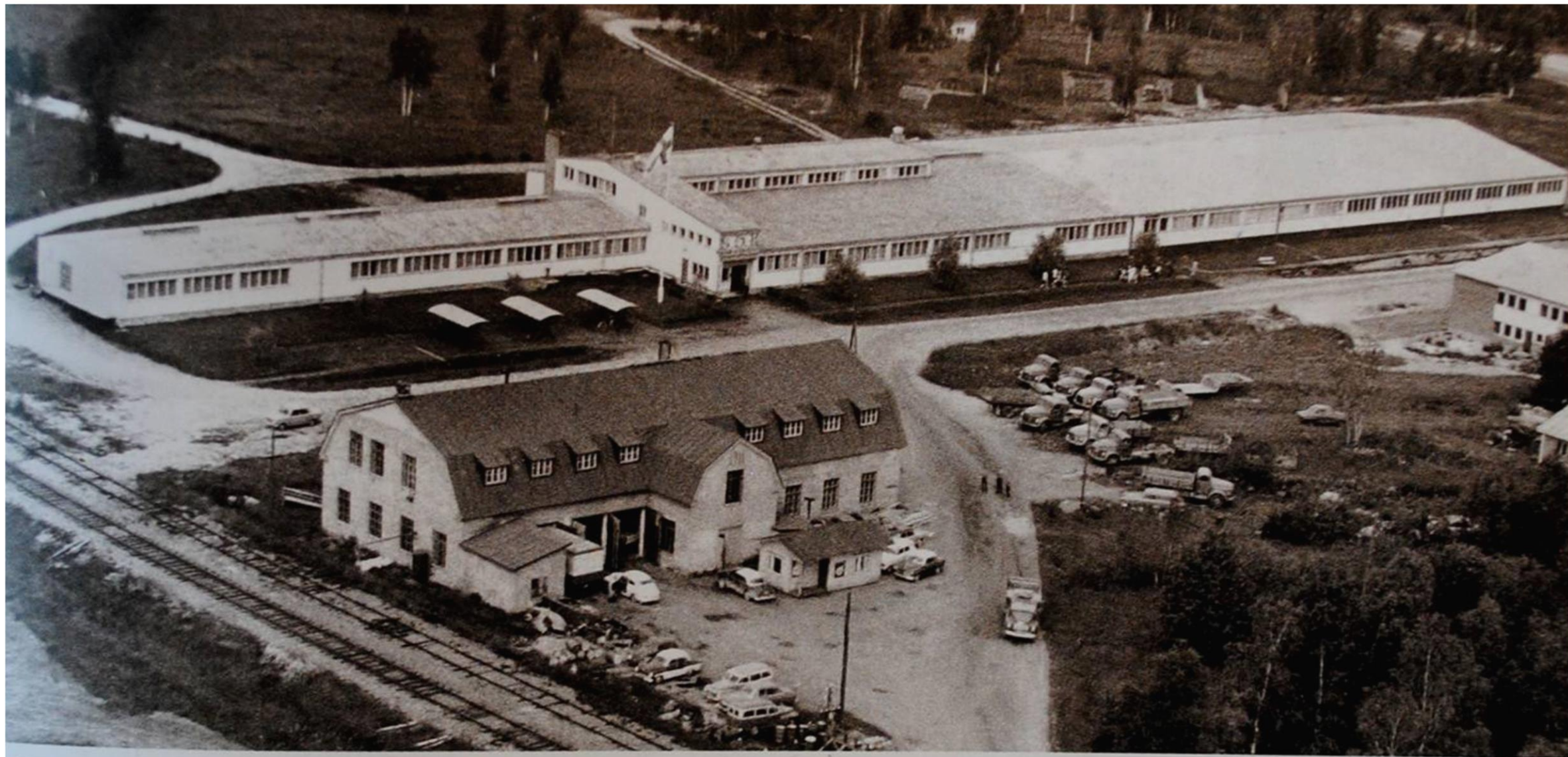
SOK:n vaatetustehdas Kokkolassa. Paitojen lisäksi tehdas valmisti suuria määriä farkkuja 1970-luvulla. Etualalla rakennus, joka alunperin oli köysitehtaan konttori. Kuvaushetkellä tiloissa toimi Auto-Haron kuorma-autojen huolto. SOK:n arkisto.
