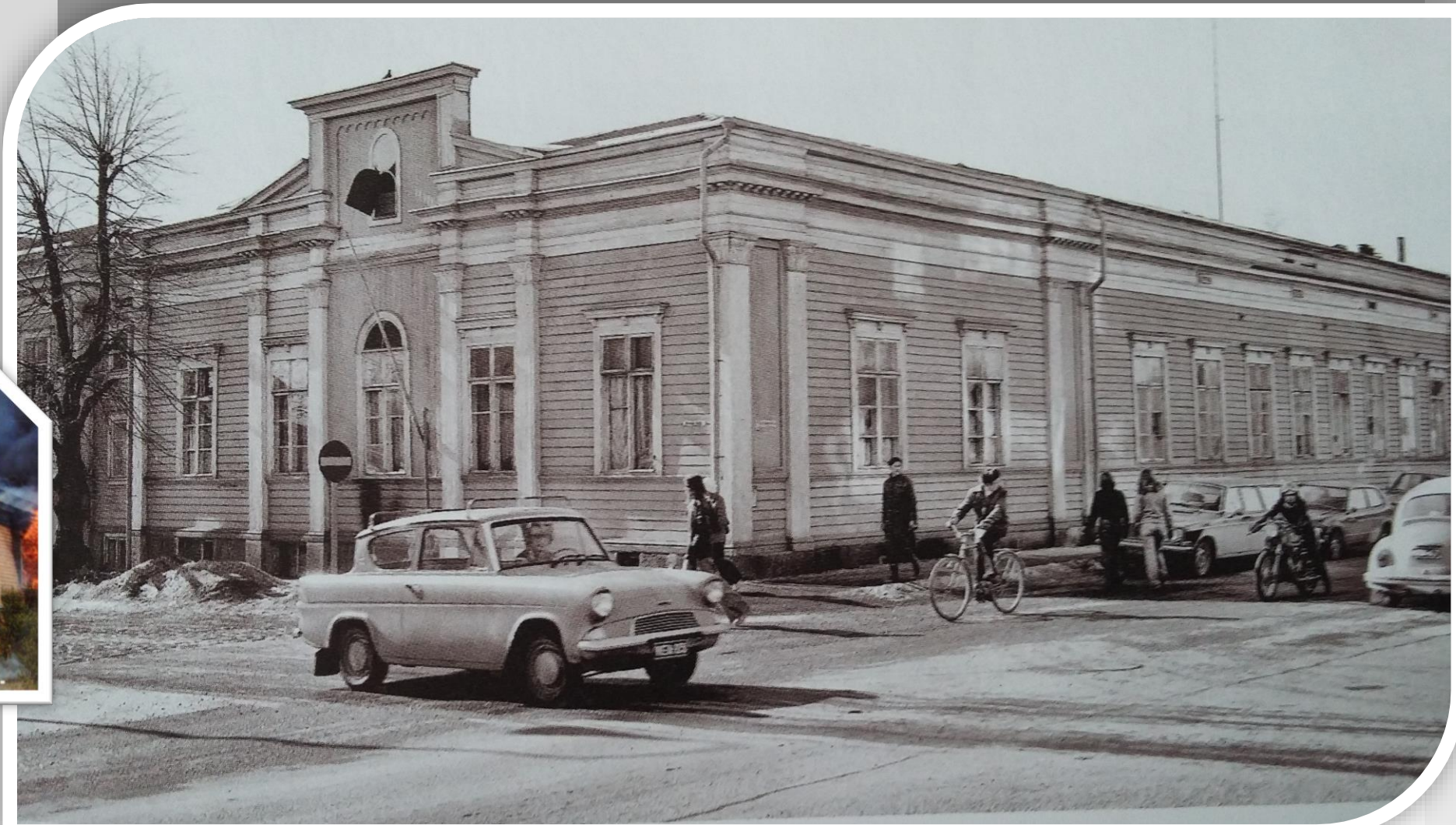
Byggnadskomplexet från 1866 fick förfalla
