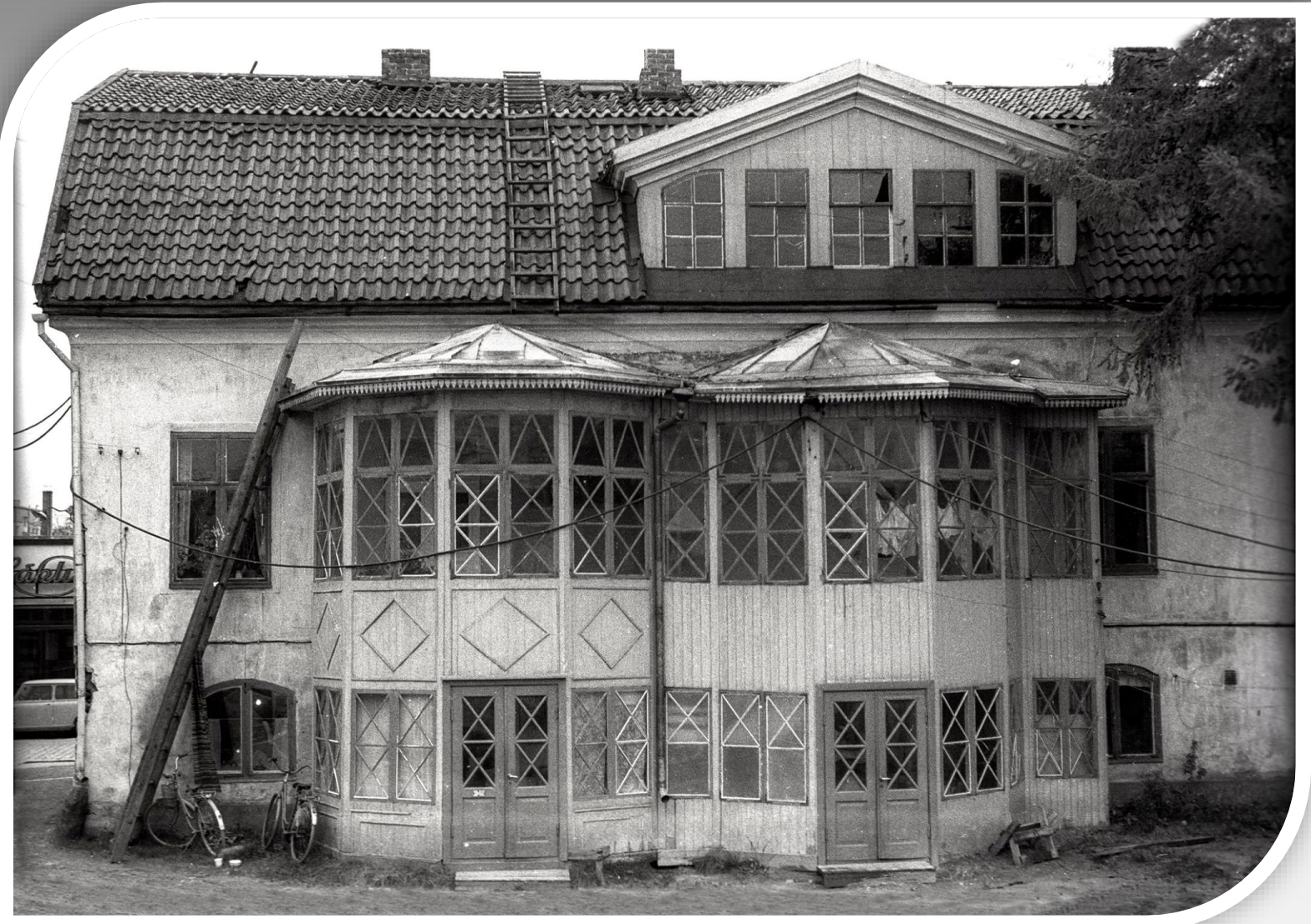
Innergården på Kyntzells hus Farstukvisten byggd 1890
