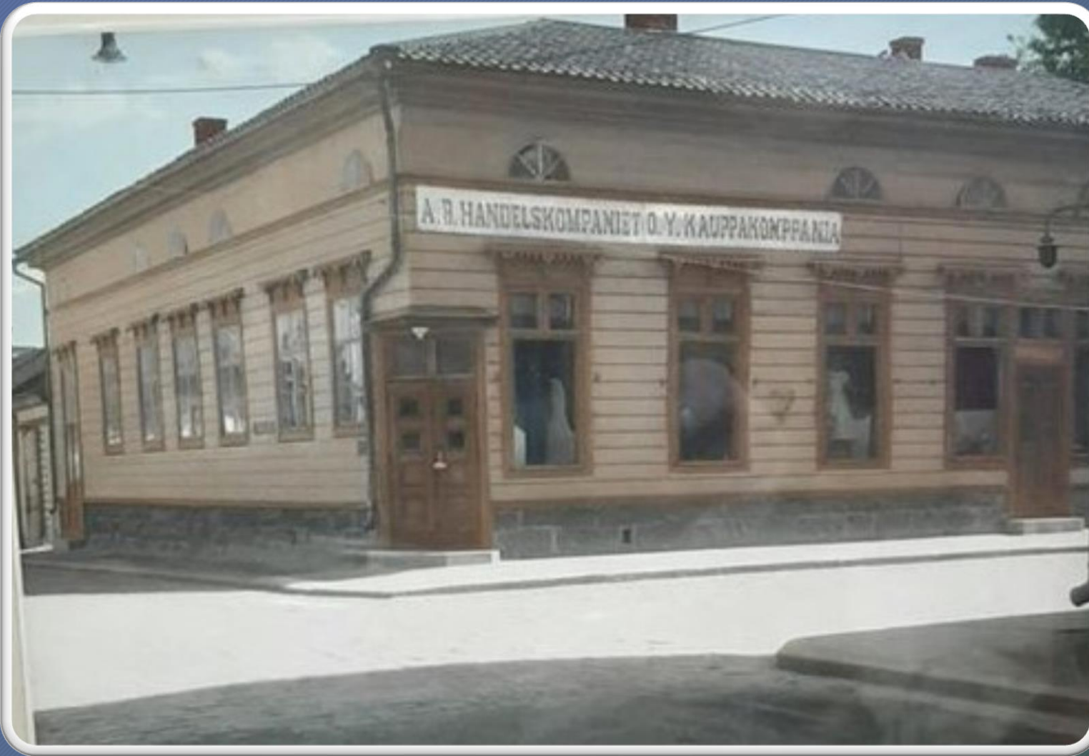
Gamlakarleby Handelskompani Ab (Jan Forséns hus, byggd 1839)
