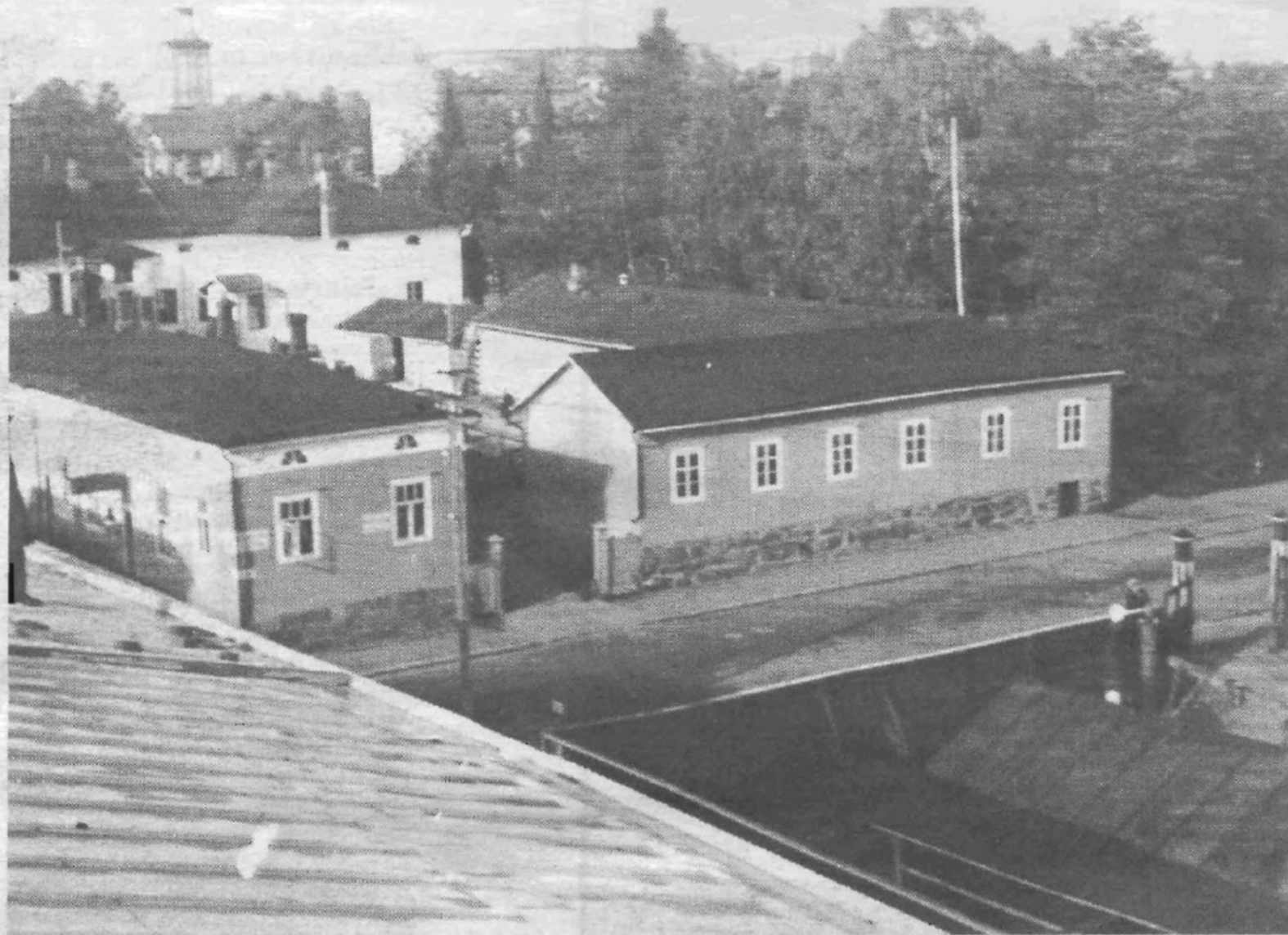
På den här bilden som är från 1941 syns byggnaderna mot Strandgatan som hörde till Öllers handelshus. Grossisten Gustaf Öller var infödd gamlakarlebybo, hans far Georg var posttjänsteman i staden. Handelshuset byggdes 1864 och var i tiderna en av de största byggnaderna i Gamlakarleby. Bilden tillhör familjen Prest.
