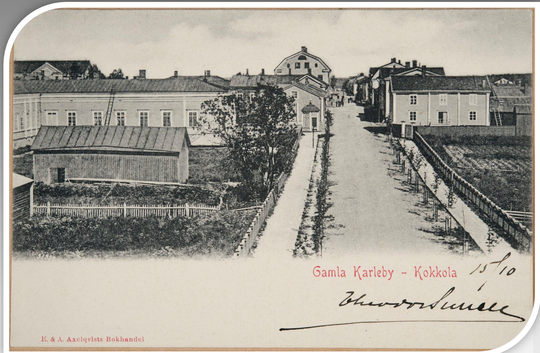
Kuva on otettu vuonna 1900 ennen ruots.yhteislyseon laajennusta . Huomioi kulmassa olevaa vesipostia.
