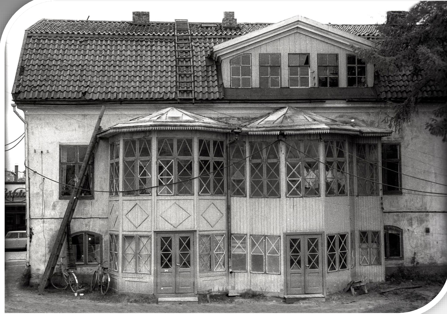
Kyntzellin talon sisäpiha Eteiskuisti rakennettiin 1890
