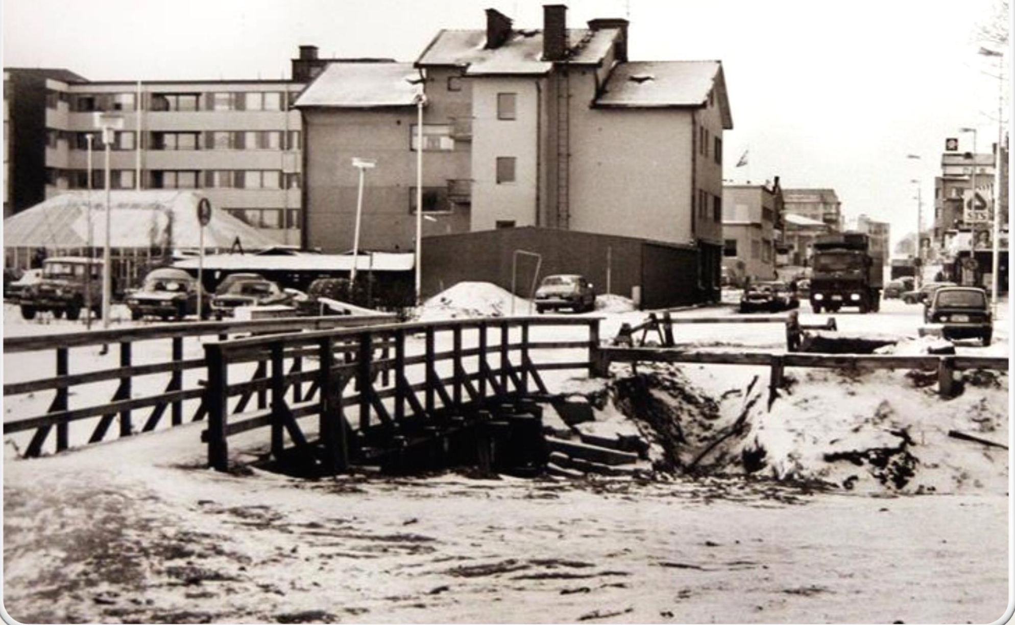
Tehtaankadun silta – "Pikkusilta"
