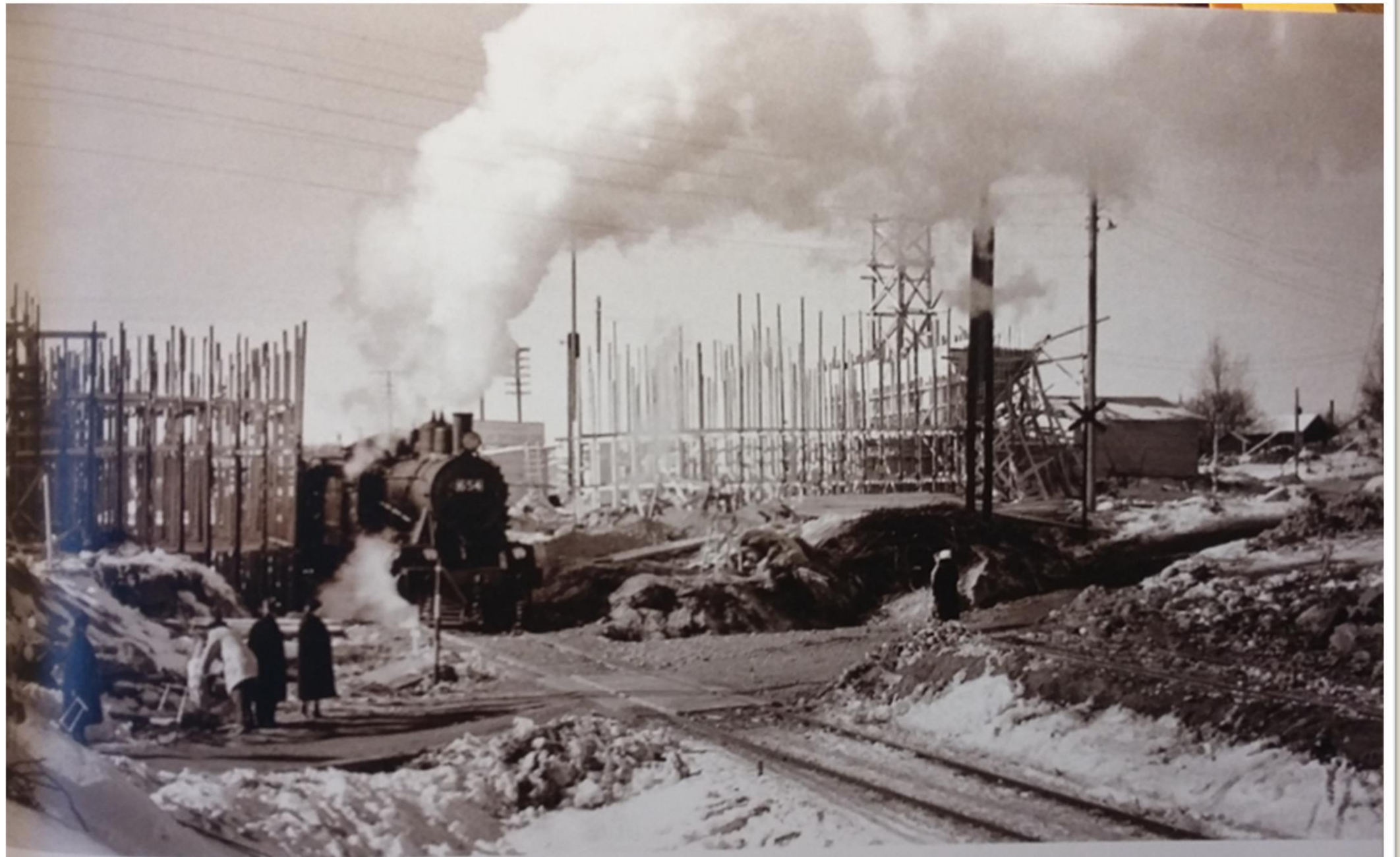
Närvilän viadukti rakennettiin vuonna 1957. Samalla rakennettiin uusi tieosa Ventukselle (Kuva: Kristian Olausson)
