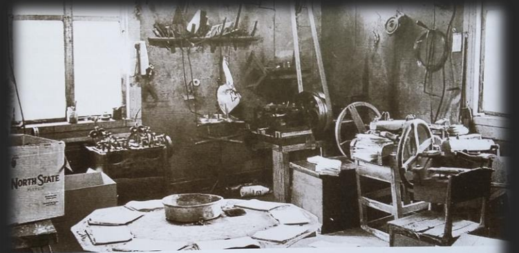
Interiör från Indolas kardfabrik som flyttats till
