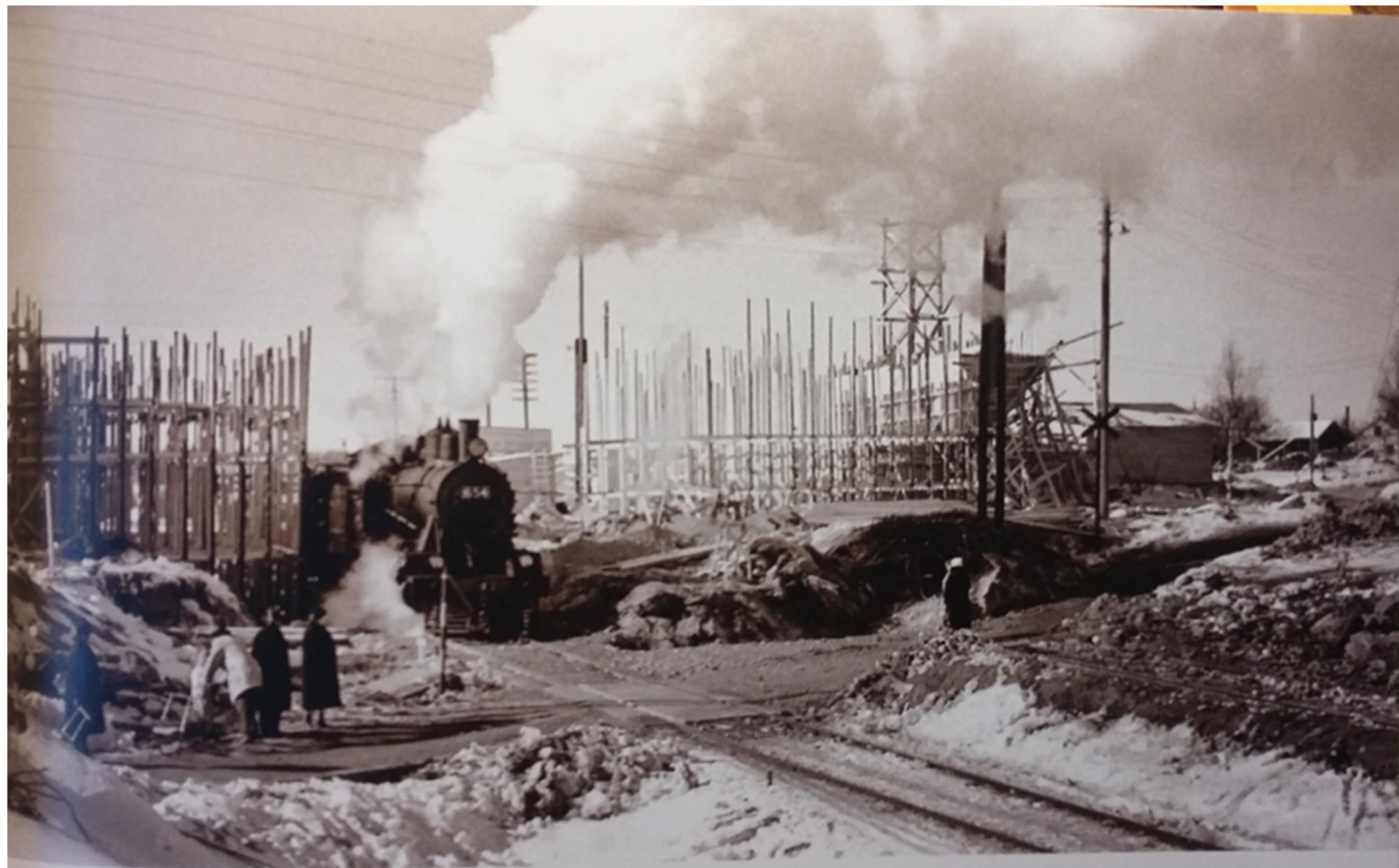
Viadukten i Närvilä byggdes år 1957. Samtidigt byggdes en ny väg från viadukten till Ventus. Kristian Olausson.
