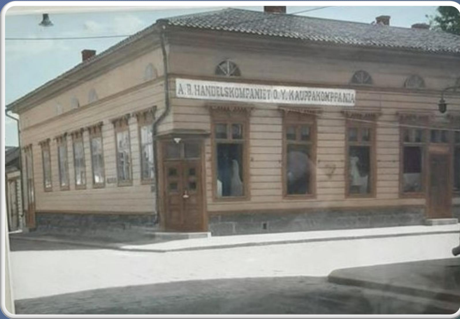
Gamlakarleby Handelskompani Ab (Jan Forséns hus, byggd 1839)
